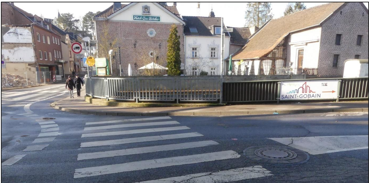
Abbildung 2.6: Fehlende Absenkung und taktiles Leitsystem am Kreisverkehr Kleikstraße/Uferstraße (Eigene Aufnahme)
