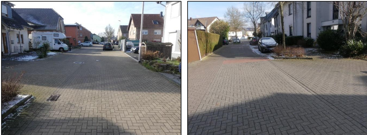
Abbildung 2.15: Querschnitte in Wohngebieten mit niveaugleicher Gestaltung (v.l.n.r.: Sophie-Scholl-Straße, An Speenbruch, eigene Aufnahmen)
