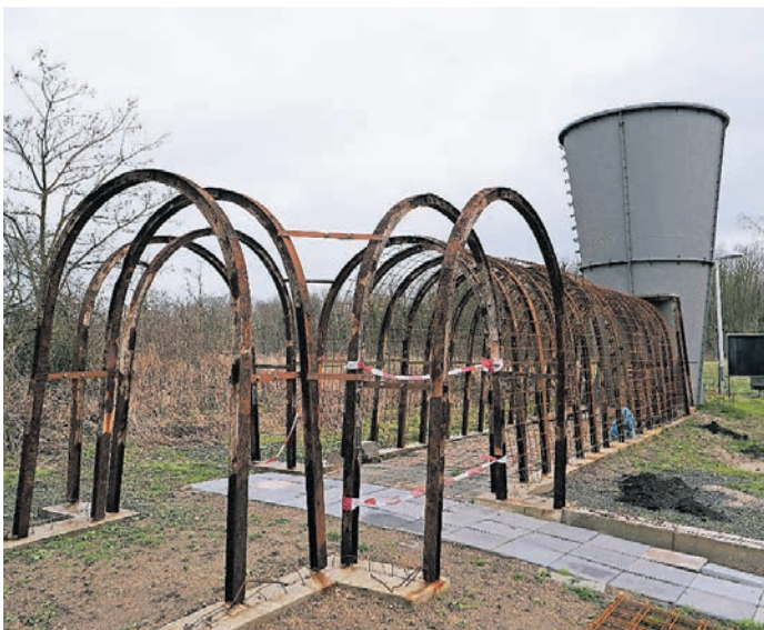
Hier entsteht die neue „Wetterstraße“ – Grubenwetter ist ein großes Spezialgebiet des Vereins.
