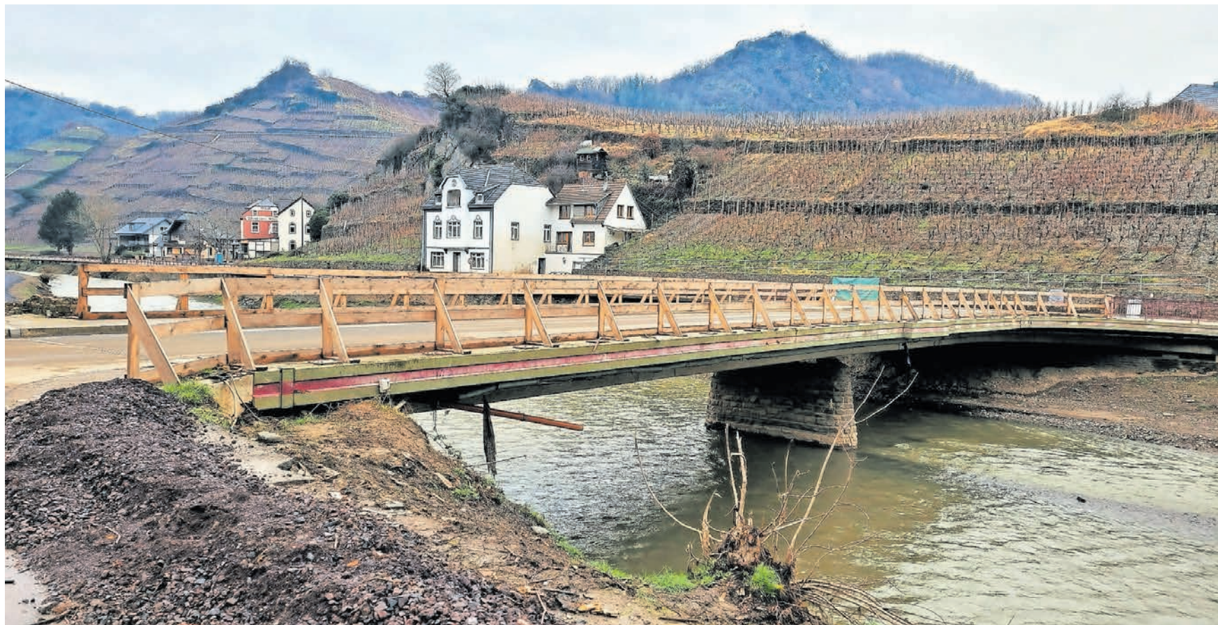
Diese Brücke über die Ahr kann zwar schon wieder genutzt werden – Arbeiten sind hier dennoch weiterhin erforderlich.
