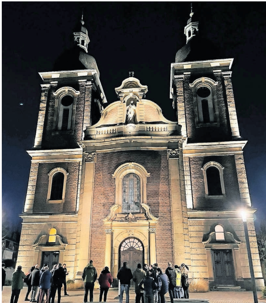
Die neue Außenbeleuchtung von Sankt Mariä Himmelfahrt setzt den Kirchenbau nach Anbruch der Dunkelheit fast schon festlich in Szene.
