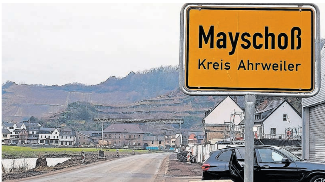
Am Ortseingang von Mayschoß: Neue Straßen durch den Ort mussten gebaut werden.
