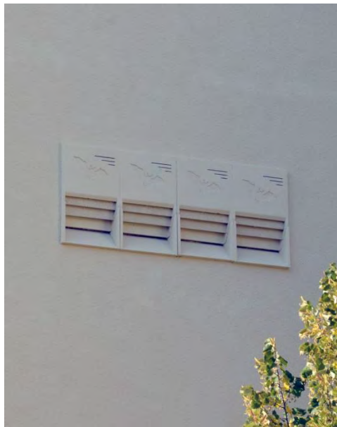
Abb. 4: Vier versenkt in eine Fassade eingebaute Fledermauskästen 2FTH mit Grundsteinen
