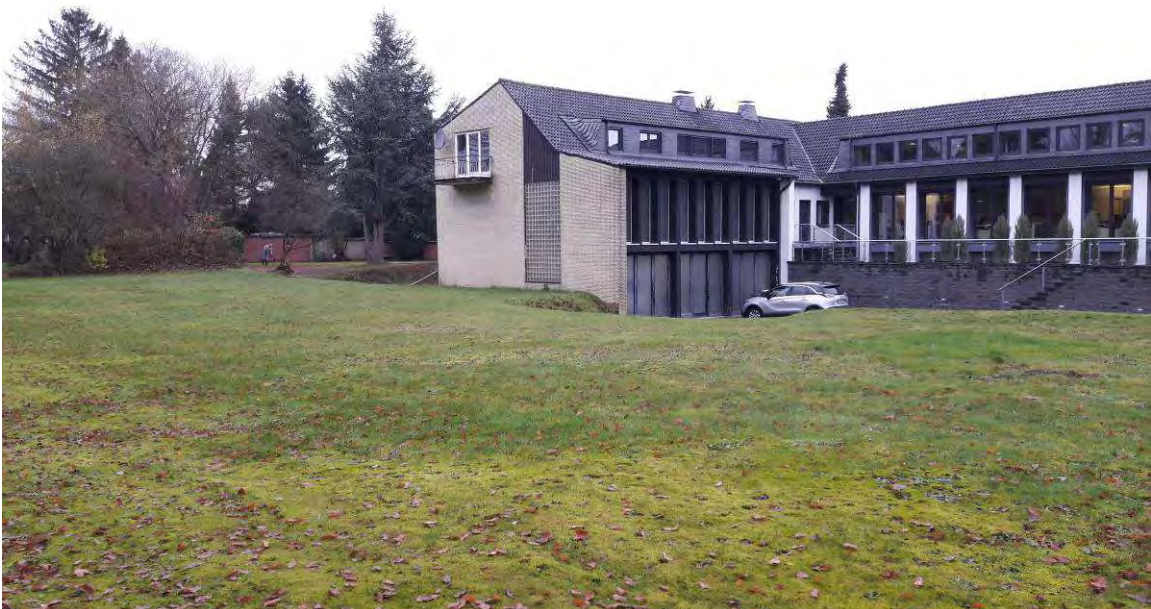
Abb. 9: Gebäude der Firma KFW im nordöstlichen Plangebiet (Foto 07.12.2020).
