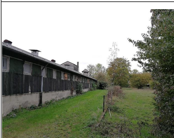
Gelände des ehem. Hühnermastbetriebs. Blickrichtung Westen: Der südliche der ehemaligen Stallungen. Die Fläche zwischen den Stallanlagen ist durchzogen von Wiese.
