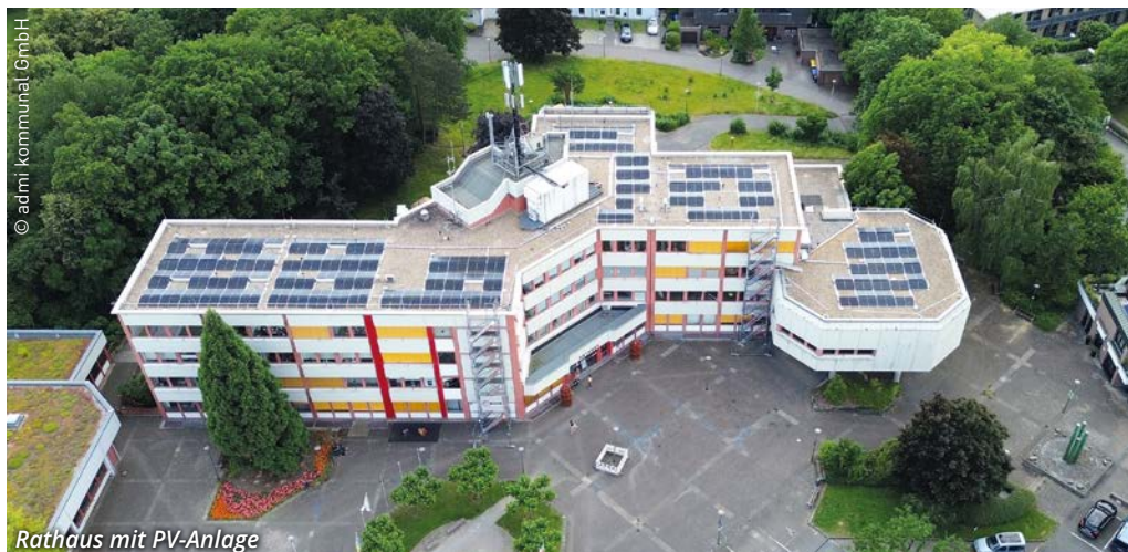
Rathaus mit PV-Anlage
