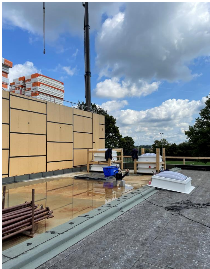
Dachbereich oberhalb Foyer
