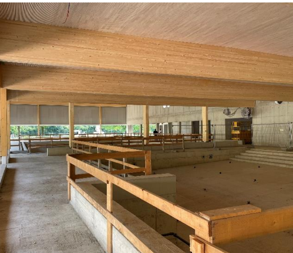
Blick auf Kombibecken in Richtung Schwimmerbecken
