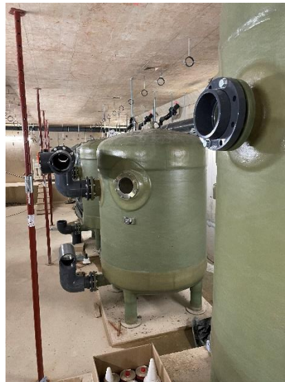
Filterkessel Untergeschoss
