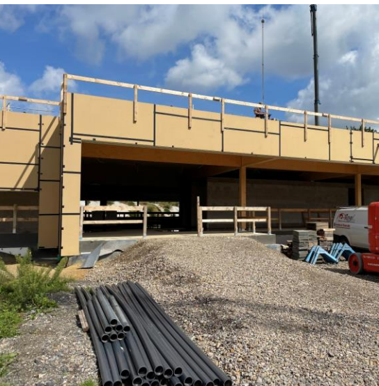
Fassade im Bereich Eingang
