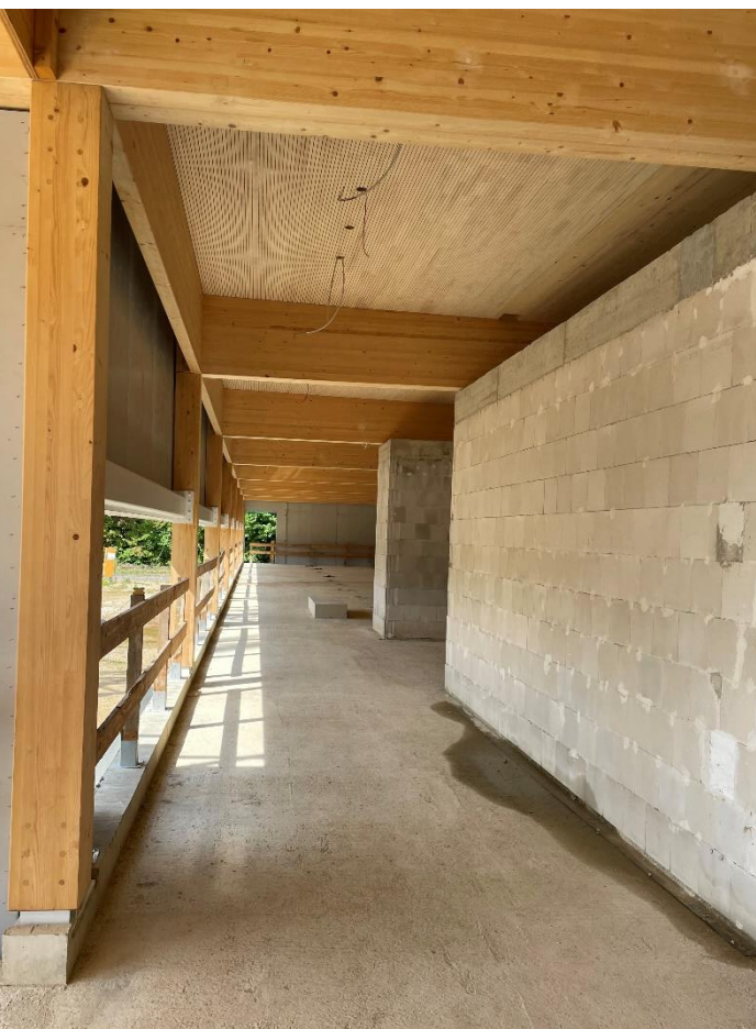
Bereich Durchgang Foyer-Richtung Umkleiden
