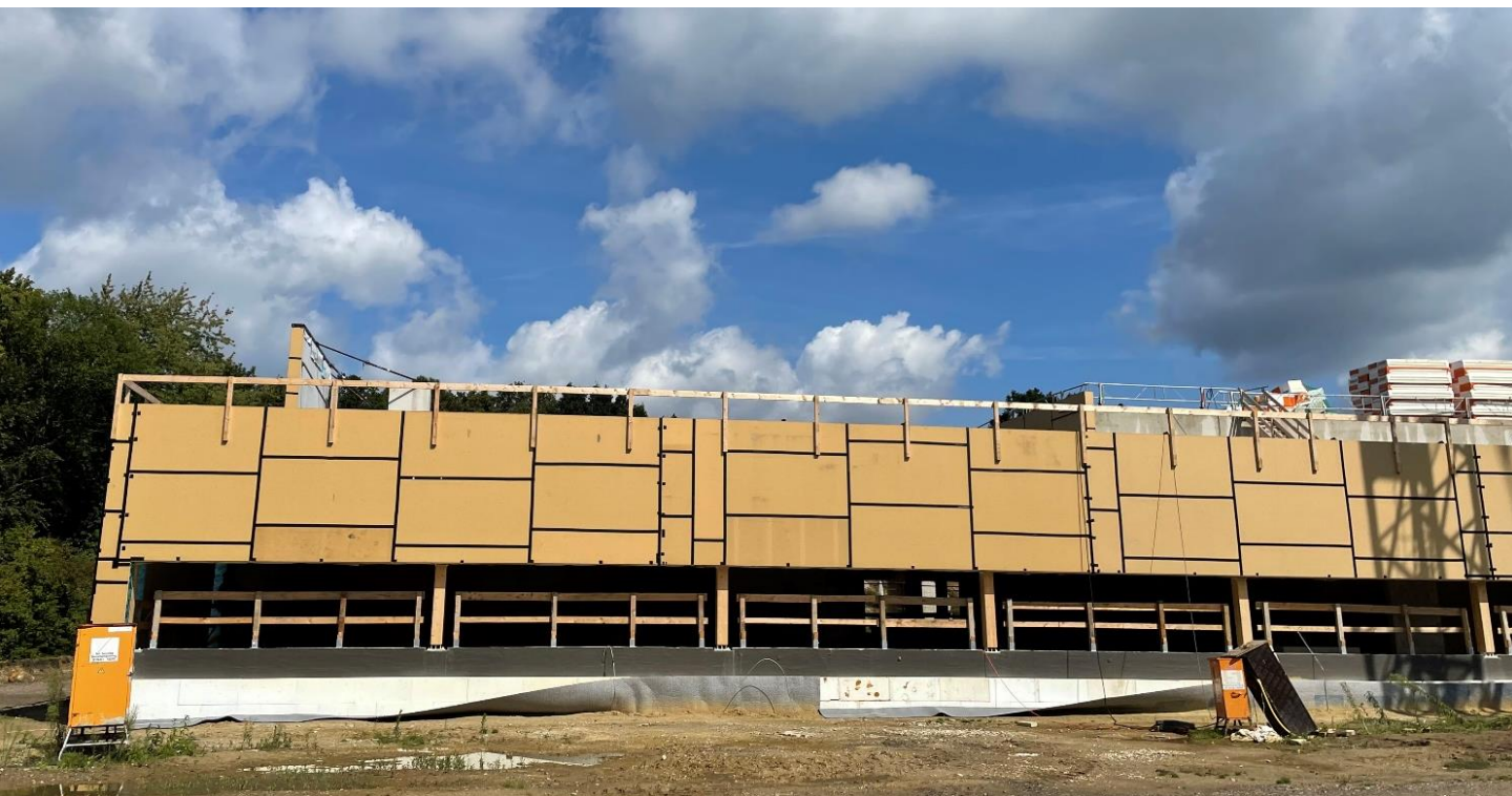
Fassade im Bereich Umkleiden
