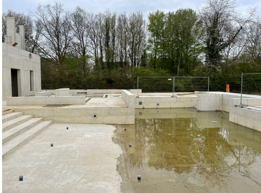
Kombibecken mit Wassergewöhnungstreppe
