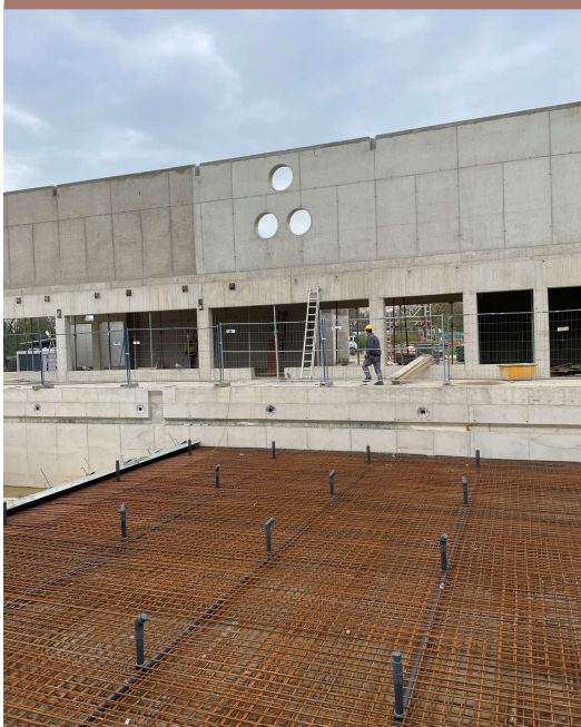
Schwimmerbecken mit Blick auf Umkleiden
