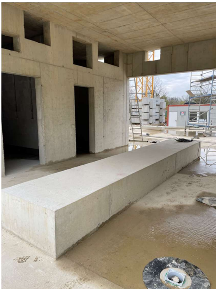
Bereich Durchgang Duschen- Umkleiden
