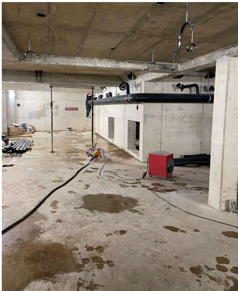
Bereich unterhalb des Kombibeckens -Verrohrung
