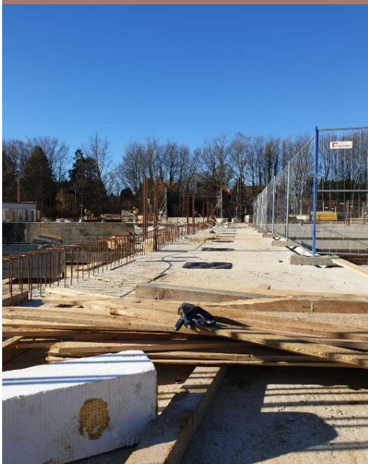
Bereich Beckenumlauf Schwimmerbecken
