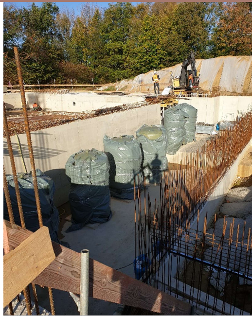
Einbau Aktivkohlefilter
