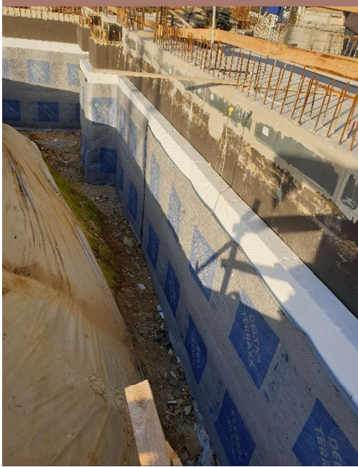
Dämmung der Außenwände
